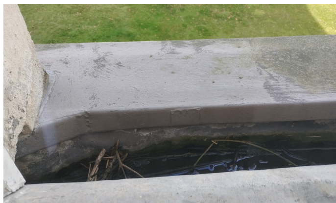
La reprise de l'étanchéité du chéneau en paxalu n'est pas pérenne La stagnation des eaux dans les chéneaux lié à des contre-pentes
