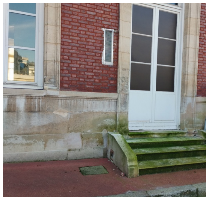
Remontées capillaires importantes sur le soubassement nord
