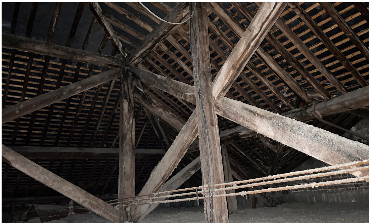
Charpente du corps central Vue des sous-faces du terrasson et des brisis
