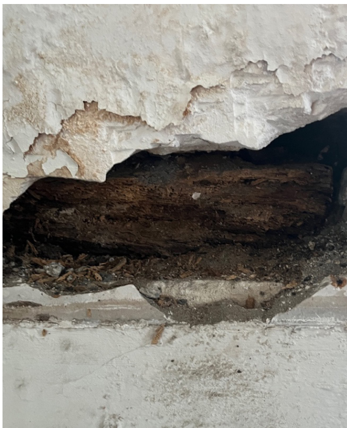
Les infiltrations par les chéneaux fuyards ont conduit à la pourriture de l'ensemble des arbalétriers en contact avec la maçonnerie
