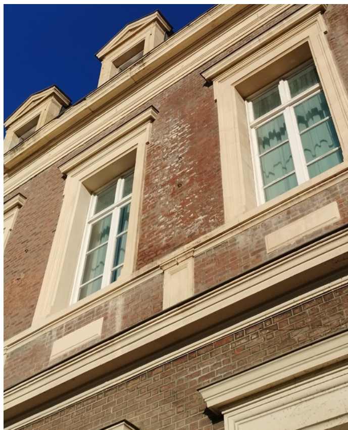
Efflorescences salines sur la façade sud au 1 er étage Entre les baies R1-S4 et R1-S5
