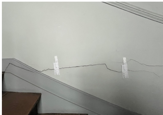
Fissuration du murs porteur dû à l'affaissement de l'escalier vers le cœur de la cage
