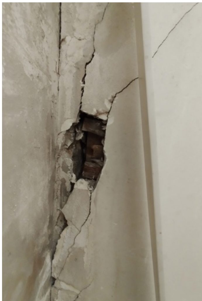
Fracture importante dans la salle de l'horloge Les fissures et fractures sont principalement concentrées sur l'axe du mur de refend longitudinal (nord) de la sous-préfecture, ainsi que sur les façades et murs de refend sud
