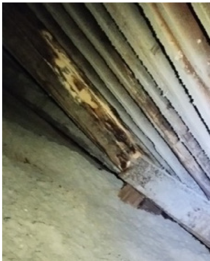
L'arbalétrier central de l'aile ouest subit l'attaque de champignons lignivores. Ils ont été observés lors de notre visite en février 2025 et non répertoriés sur les sondages précédents. Il y a donc une forte évolution parasitaire au sein de l'édifice.
