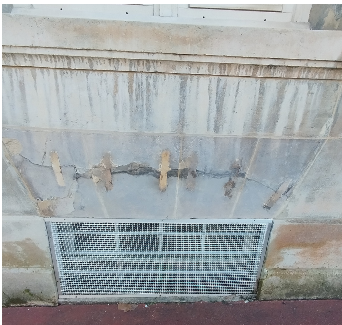
Claveaux des soupiraux agrafés Façade nord
