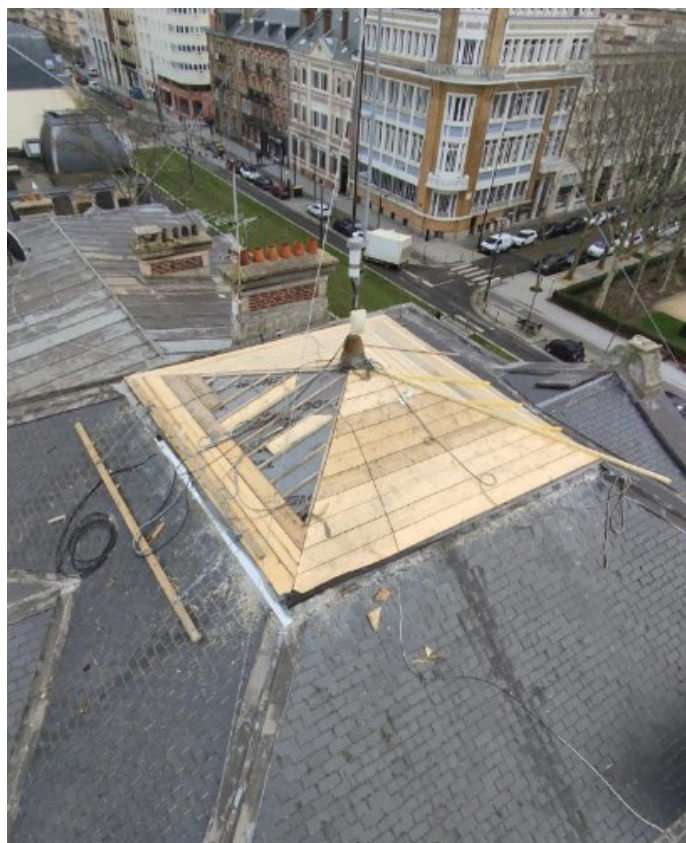
Terrasson central étanchéisé, re-voligé, solin en zinc remplacés.
