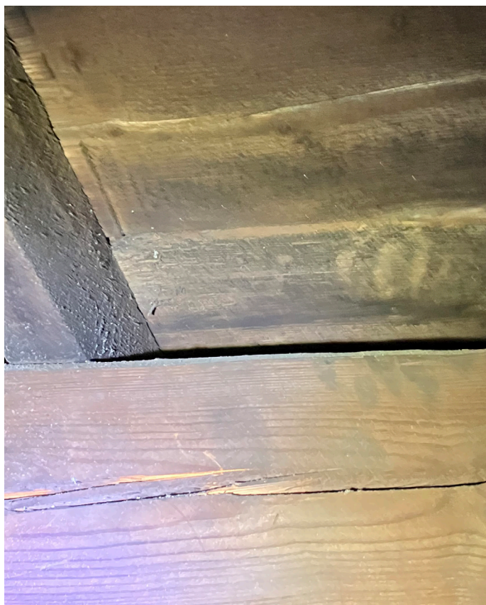
Gerces horizontales présentes sur de nombreux éléments de la charpente
