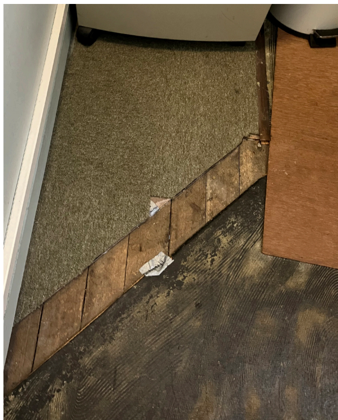
Sol d'origine en parquet à l'anglaise recouvert de colle à revêtement souple (partie noire)
