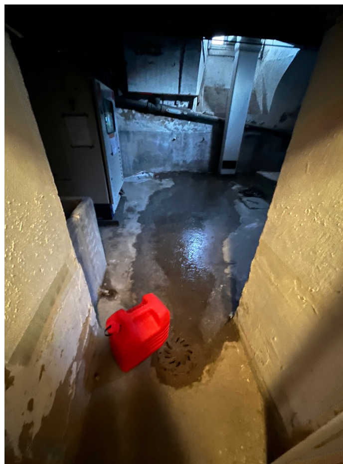
Infiltration d'eau par les soupiraux, remontées capillaires par cuvelage défaillant. Écoulement des eaux vers siphons trop peu nombreux
