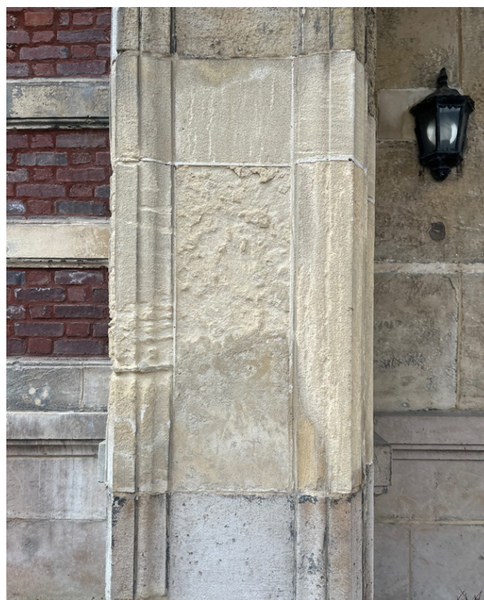
Pathologie de la pierre au niveau du péristyle nord Désagrégation de certains blocs de pierre
