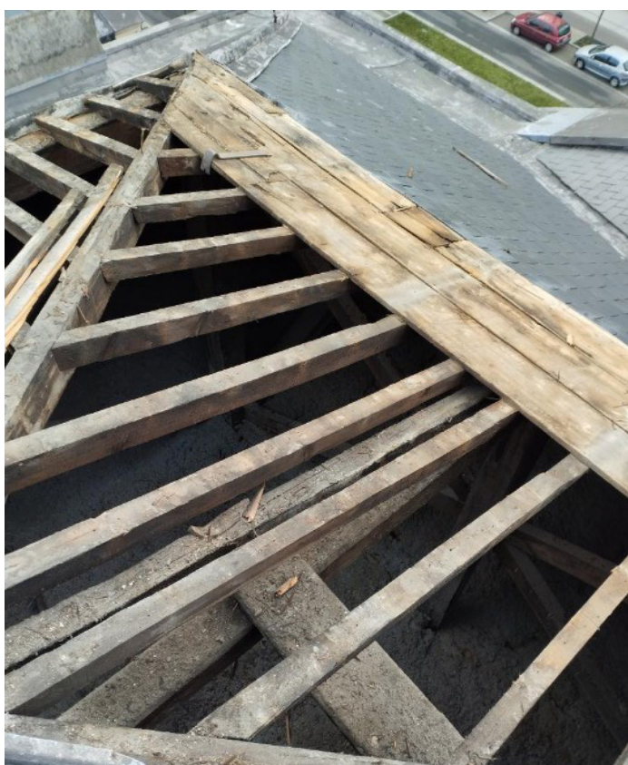
Etat de la charpente du terrasson central avant intervention
