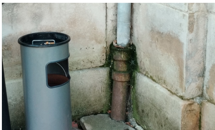
Décrochage et mauvaise jonction du système de descente d'EP
