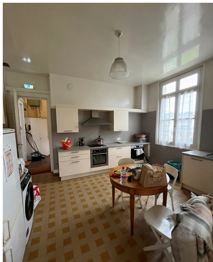
Cuisine R1-23-24: Carrelage en surépaisseur Hauteur sous-plafond surbaissée Parois et plafond laqués/carrelés
