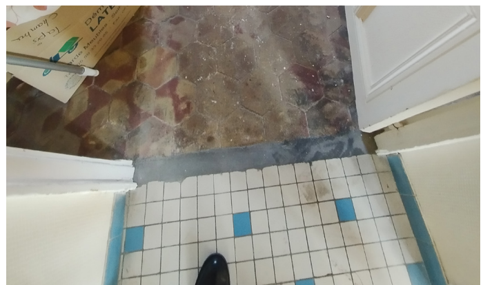
Chappe ciment armée (bas) en sur-épaisseur du sol initial en tomette (haut)
