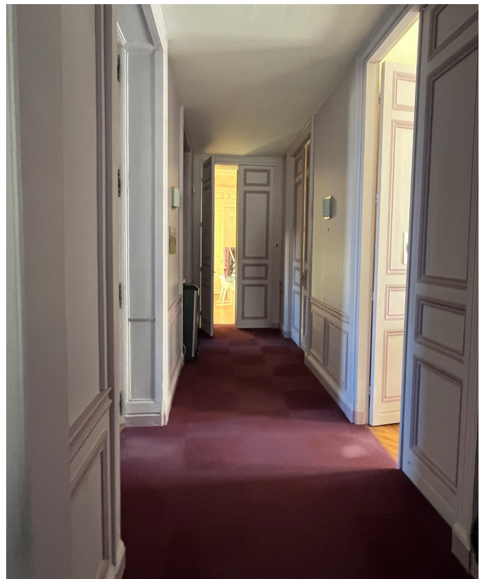
Dégagement Rdc Ro-22: Moquette en dalles Faux-plafond plâtre Lambris de soubassement
