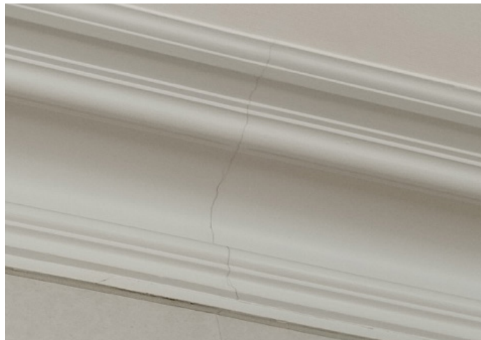
Fissures et microfissures de plafond Essentiellement visibles au niveau des corniches
