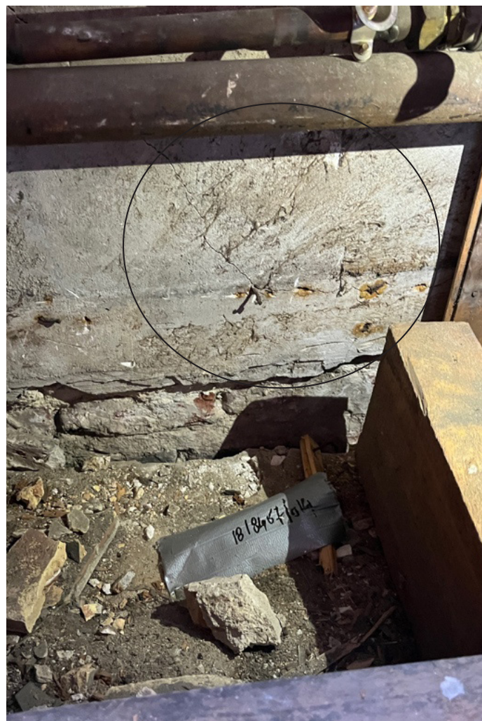
Mérule présente derrière les lambris bois de la salle des archives Probablement infestation derrière tous les lambris
