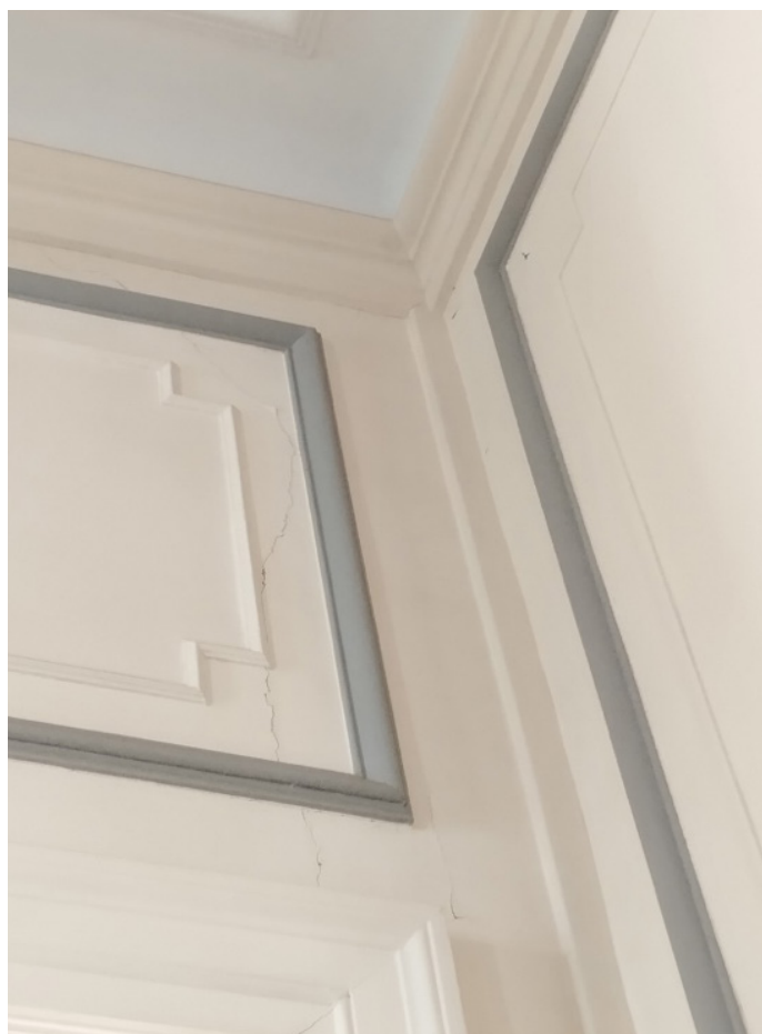
Microfissures sur les enduits de panneaux de bois du linteau de la porte d'accès à la salle à manger
