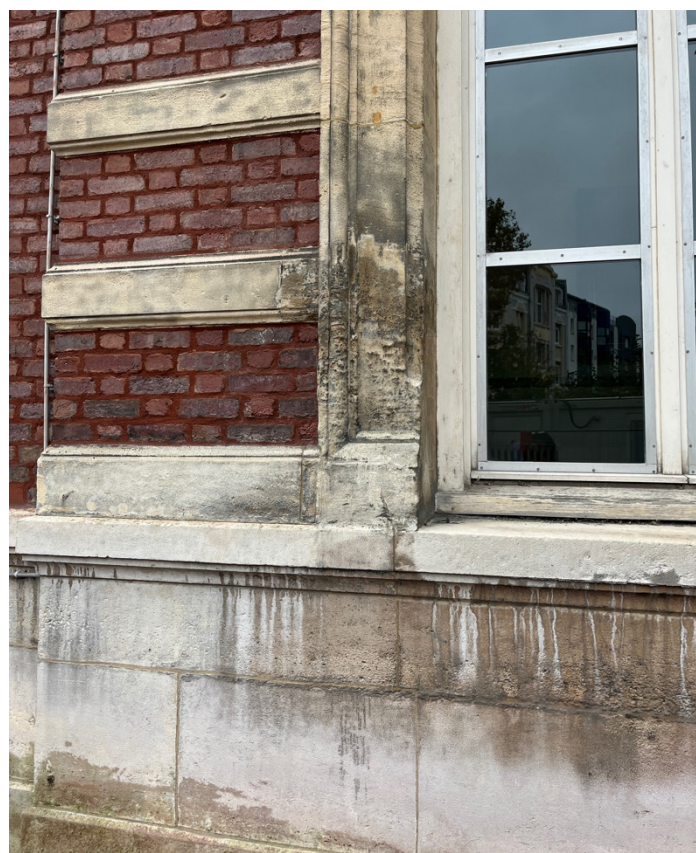
Salissures au droit des appuis de fenêtres de la façade nord
