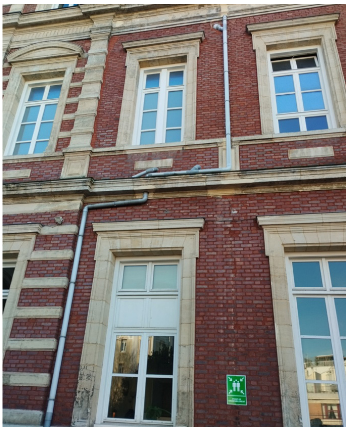
Les descentes d'EP et d'EU sont mélangées sur la façade nord Sortie de tuyaux inesthétiques
