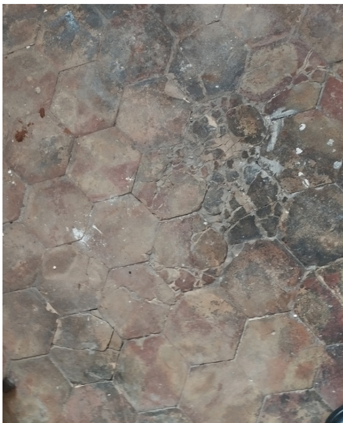
Fissuration, casse, salissures, usure des tomettes dû notamment aux usages des pièces servantes (buanderie, lingerie...)
