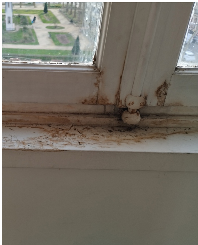
Menuiserie ancienne, laissant s'infiltrer l'eau et l'eau Pourriture des bois favorisant l'installation d'insectes xylophage et de champignons lignivores
