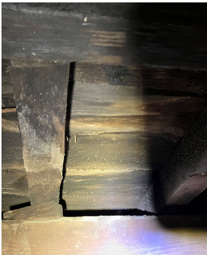
Absence de membrane pare-pluie en sous-face de couverture Infiltration d'eau dans les charpentes
