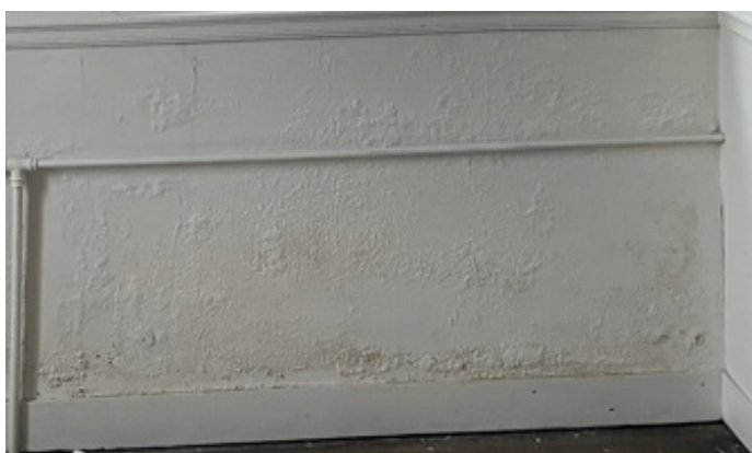
Infiltration d'eau par les grilles d'aérations ou réseaux de plomberie intérieurs (haut) Pulvérulence des parties basses des murs du 2nd étage (bas).
