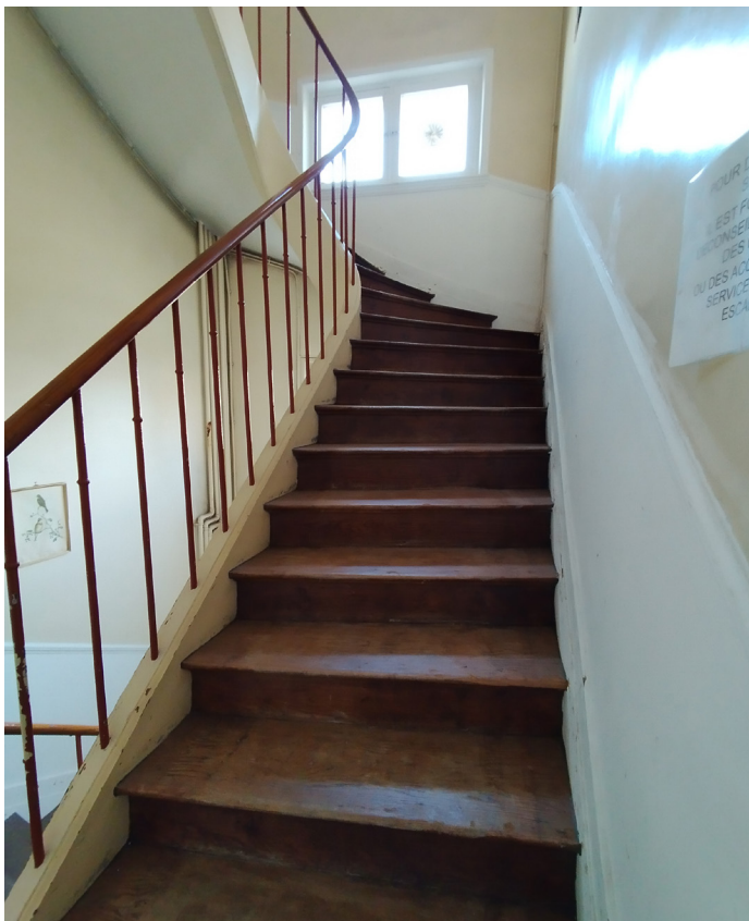
Escalier R1-22 Cimaie à hauteur d'appui, Marche et contre-marche en bois
