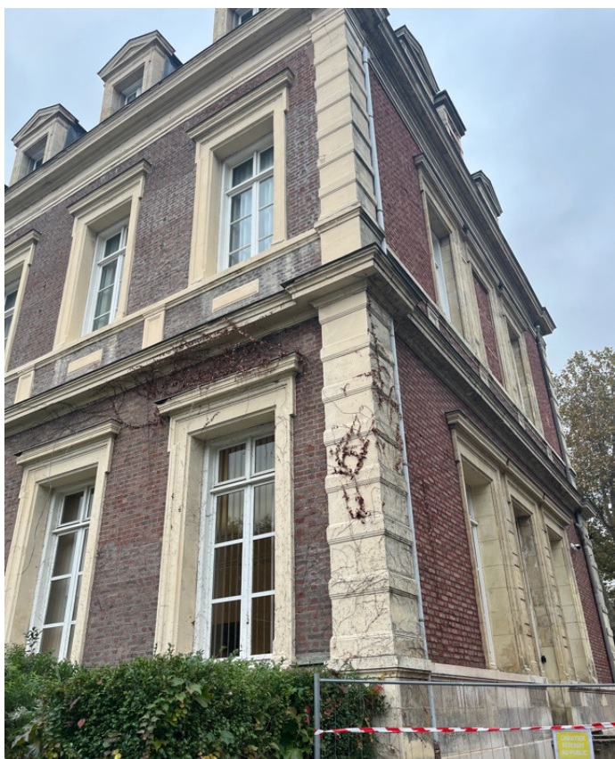
Végétation spontanée sur le pilastre d'angle Recouvrement d'une peinture imperméable sur l'ensemble des pierres de la façade sud
