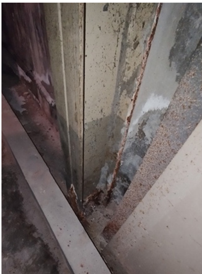
Corrosion des fermes métalliques du sous-sol en contact avec l'humidité du sol et des remontées capillaires
